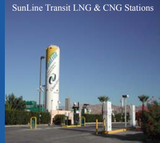
SunLine Transit LNG & CNG Stations
